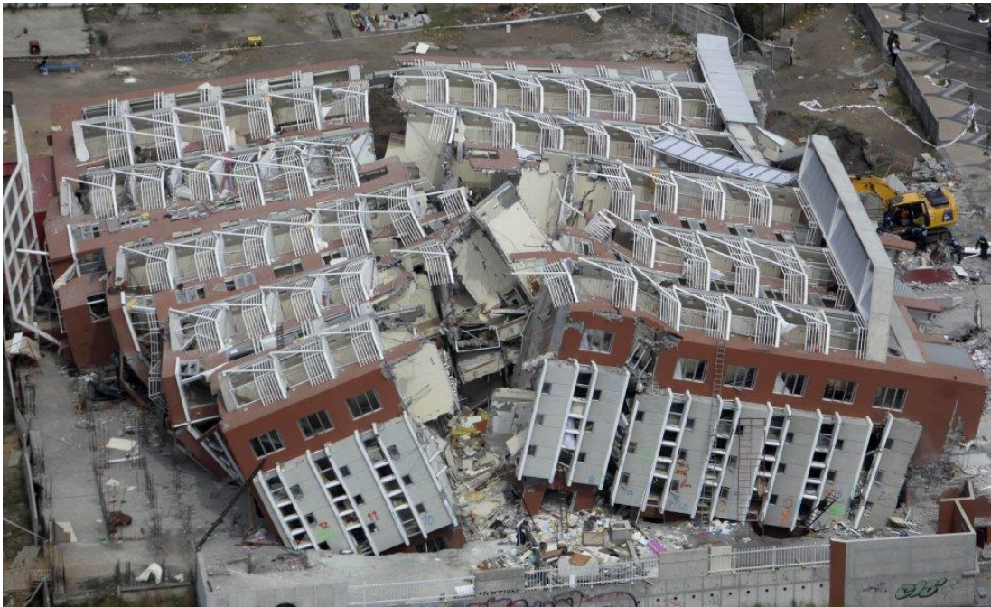
Vista aérea de un edificio colapsado en Concepción, Chile, el 27 de febrero de 2010. Autor: NATACHA PISARENKO
